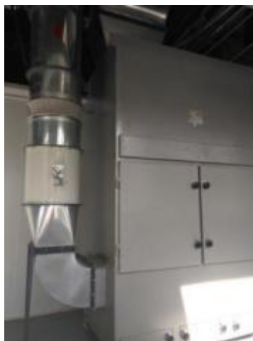
照片 8：粉尘收集回收装置
