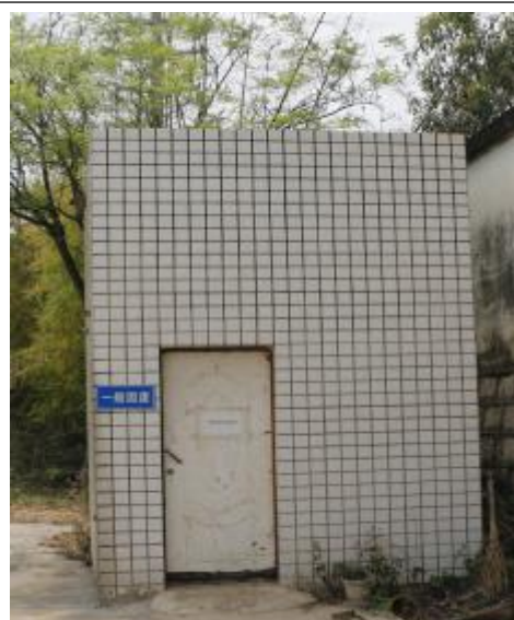
照片 12：一般固废暂存间
